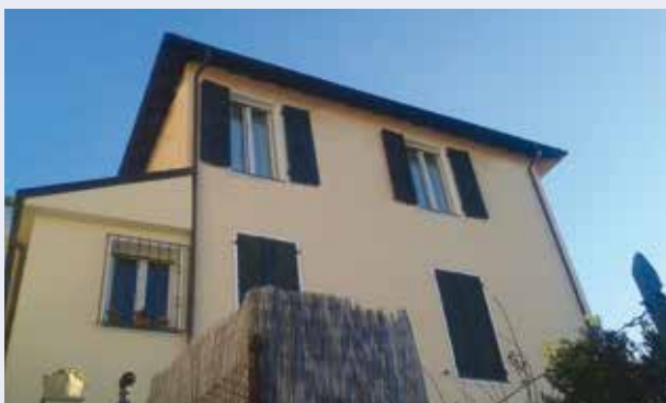
Facciata esterna di una palazzina ad Imperia
