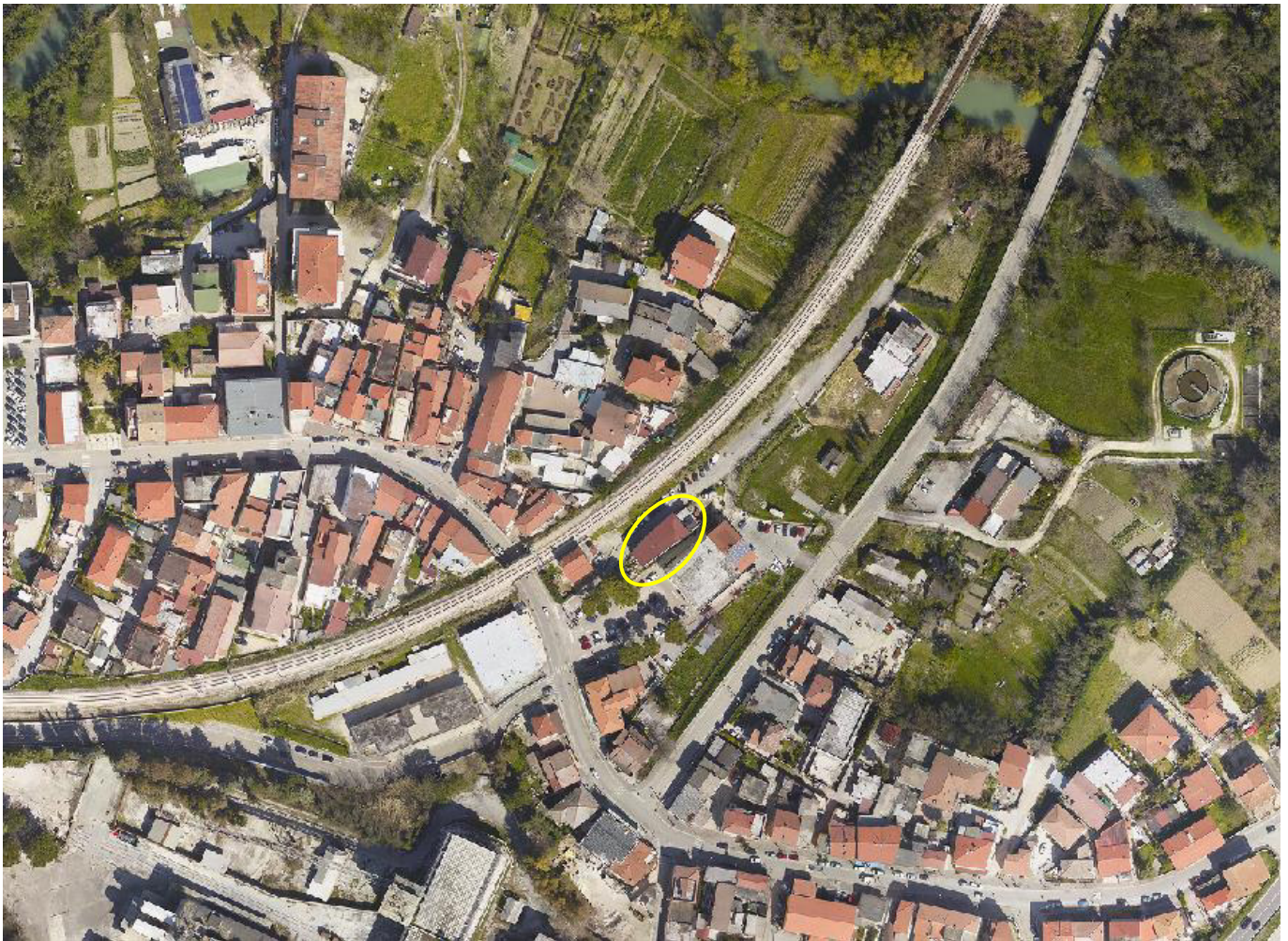
Fig. 50 – Vista planimetrica Fabbricato 37
