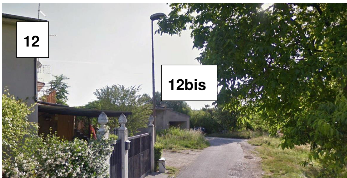
Fig. 21 - Vista Fabbricati 12 e 12bis
