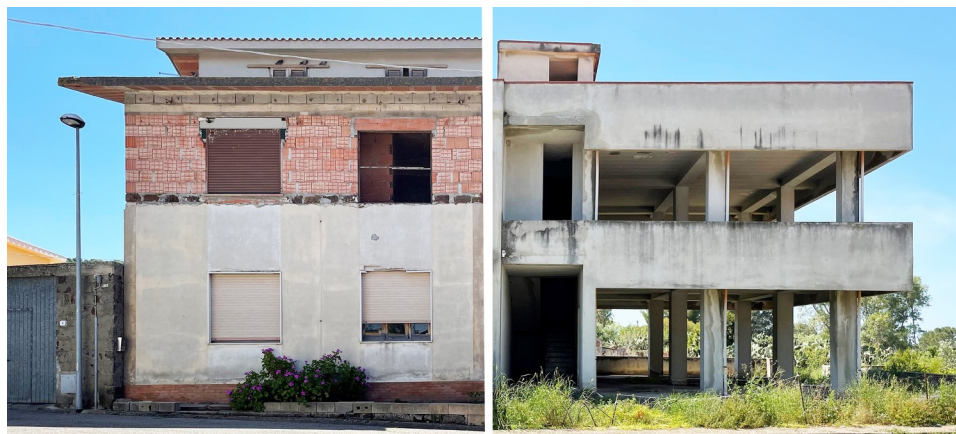
Figura 1: Il non finito sardo, espressione dell'abbandono dell'interesse pubblico di appartenere a una comunità, che ha portato alla realizzazione di abitazioni con facciate non concluse, in favore di un'attenzione esasperata per la privacy e lo spazio privato interno. Fonte: Comune di Bauladu (OR), Sardegna, Italia.
