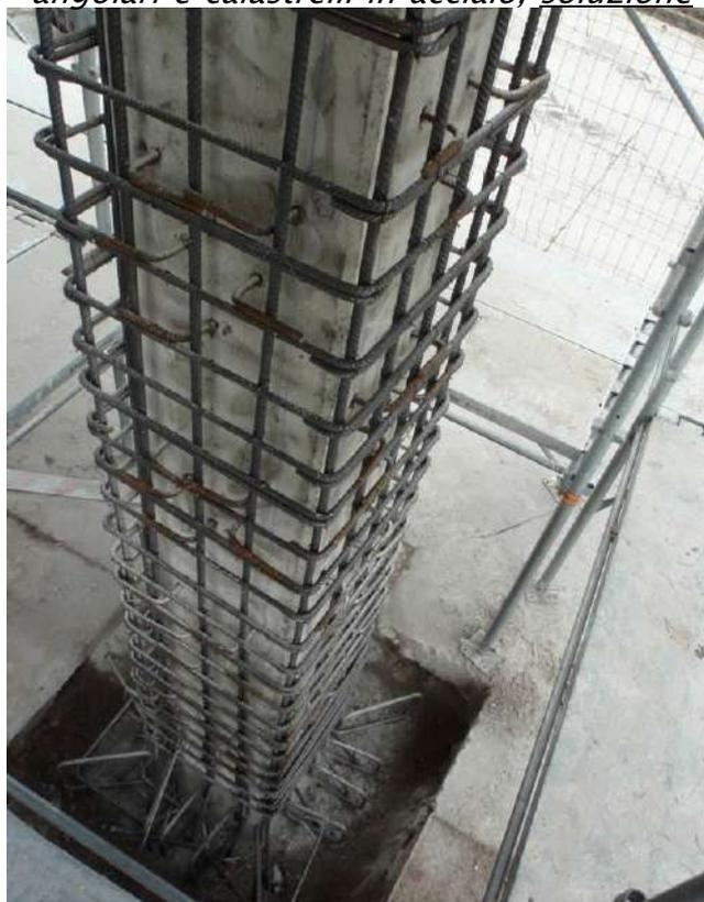
Sulla base delle valutazioni sopra esposte si ritiene necessario procedere ad un intervento di rinforzo dei pilastri esistenti mediante incamiciatura degli stessi, volto a integrarne e migliorarne le capacità di resistenza. Sono state quindi prese in rassegna due differenti modalità esecutive: una prevede l'impiego di profili angolari in acciaio e calastrelli e la seconda l'esecuzione di un'incamiciatura in c.a. con barre d'armatura adeguatamente spinottate nella fondazione esistente.
