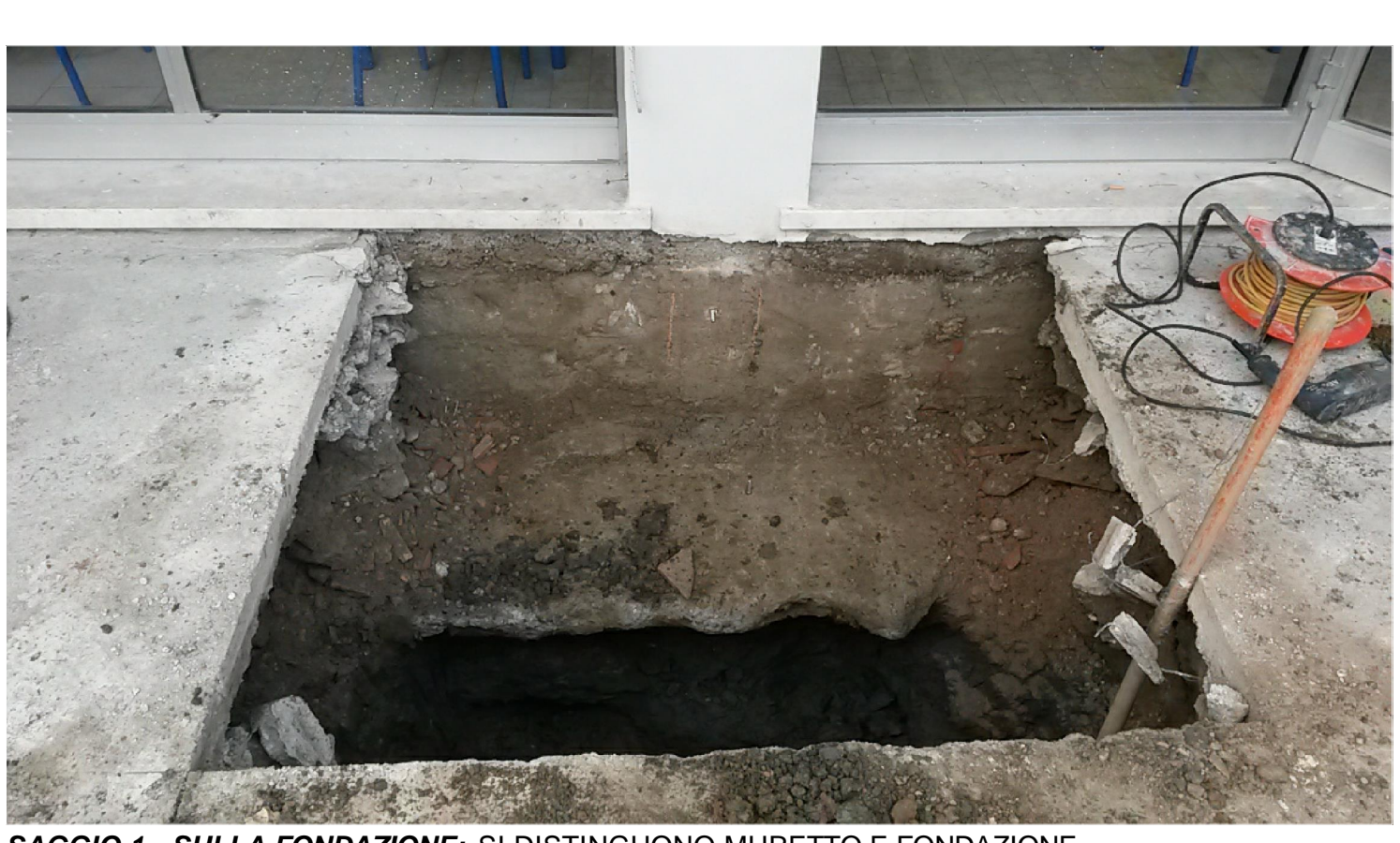
SAGGIO 1 - SULLA FONDAZIONE: SI DISTINGUONO MURETTO E FONDAZIONE
