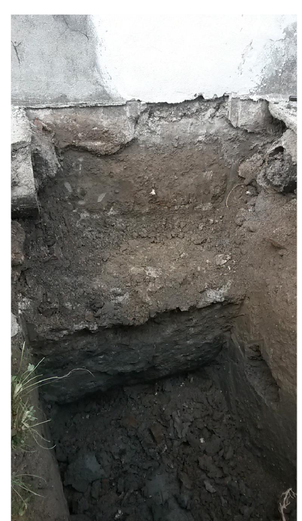
SAGGIO 2 FONDAZIONE: SI DISTINGUE LA RETE FOGNARIA
