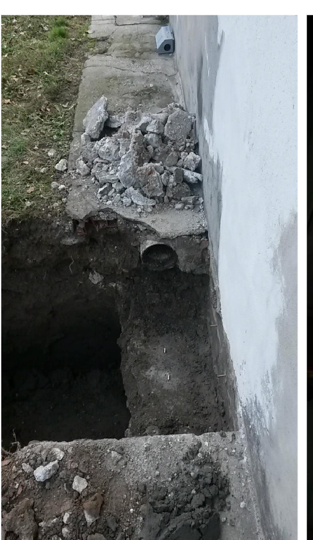
SAGGIO 2 FONDAZIONE: SI DISTINGUE LA RETE FOGNARIA
