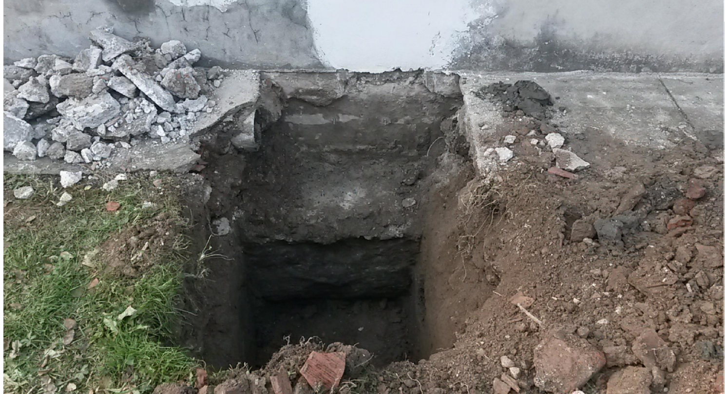
SAGGIO 2 - SULLA FONDAZIONE: SI DISTINGUONO MURETTO E FONDAZIONE
