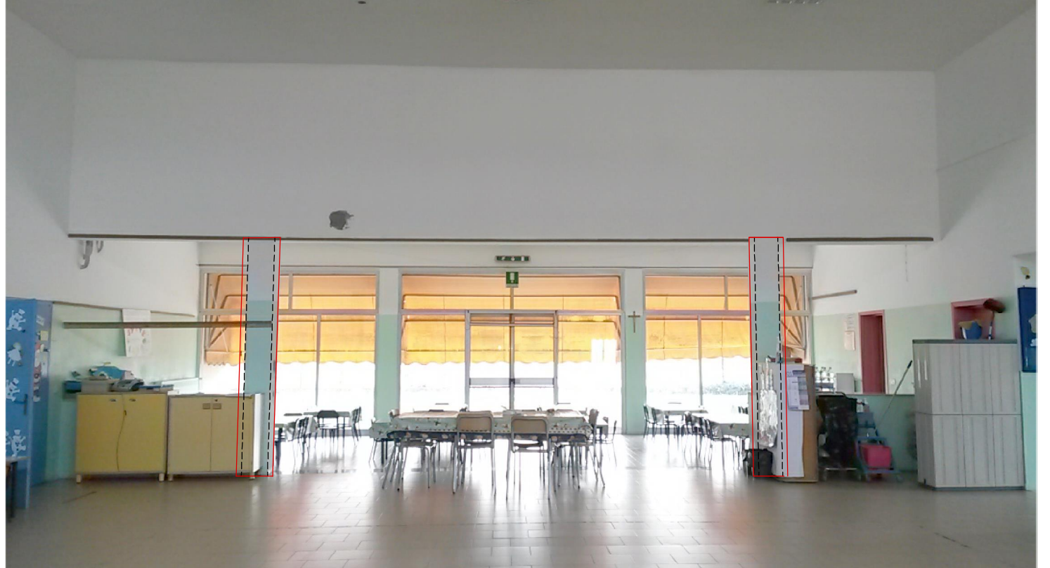
SCHEMATIZZAZIONE DEGLI INTERVENTI DI INCAMICIATURA DEI PILASTRI SU DI UNA FOTOGRAFIA CHE RITRAE LA MEDESIMA VISTA OFFERTA DALLA SEZIONE C-C
