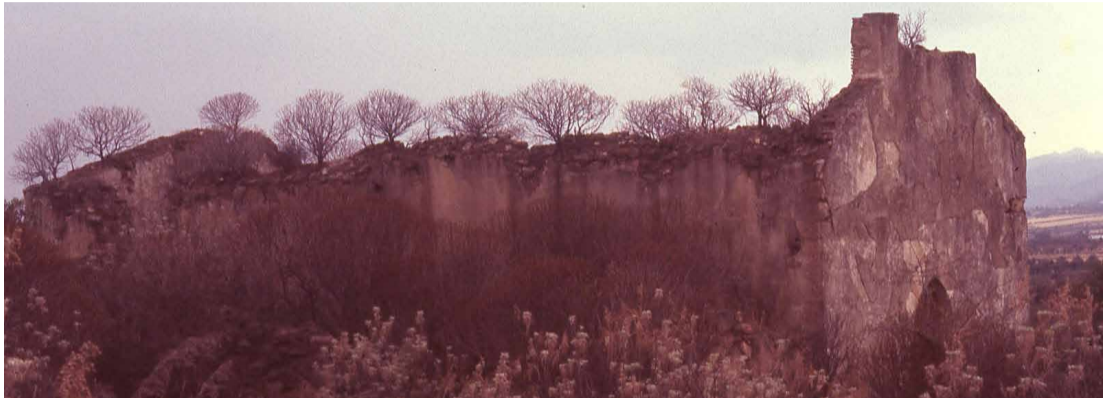
La Chiesa prima del restauro - Foto di Marco Cois
