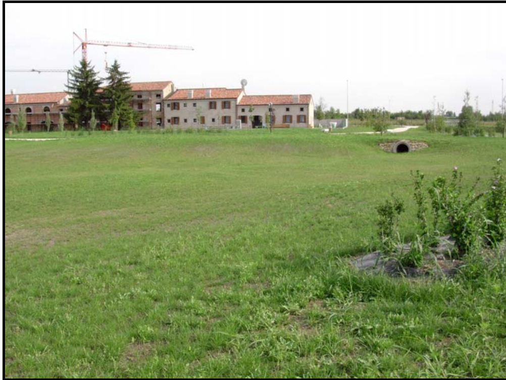
Figura 43: esempio di bacino di laminazione inserito in un'area a verde in Provincia di Verona
