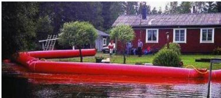
**Figura 38** – Barriera temporanea antiesondazione riempita ad aria
