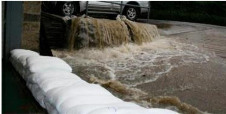
**Figura 37** – Barriera temporanea in sacchi riempiti con materiale sintetico assorbente
