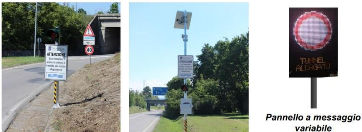
**Figura 45** – Esempi di installazioni di semafori e pannelli a messaggio variabile collegati a sensori e telecamere
