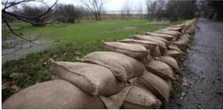
**Figura 36** – Barriera temporanea antiesondazione in sacchi di sabbia
