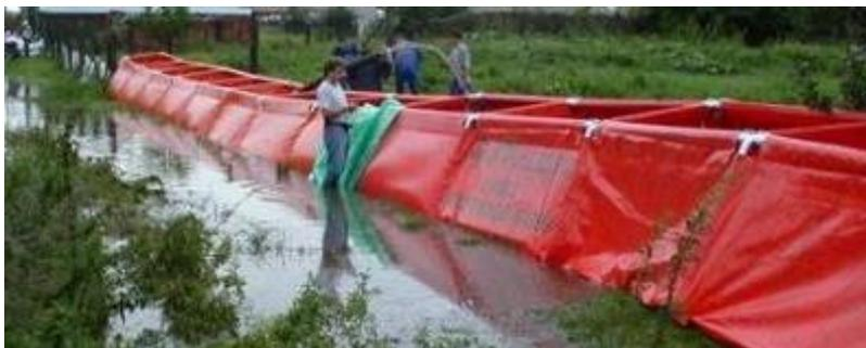
**Figura 39** – Barriera temporanea antiesondazione riempita ad acqua
