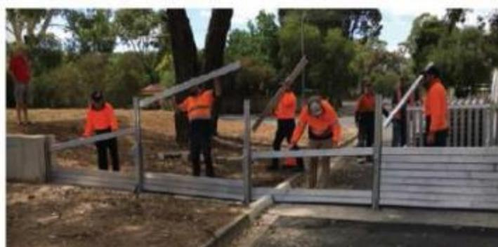
*Figura.41 – Barriera temporanea modulare con pilastri e panconi manuali in alluminio*
