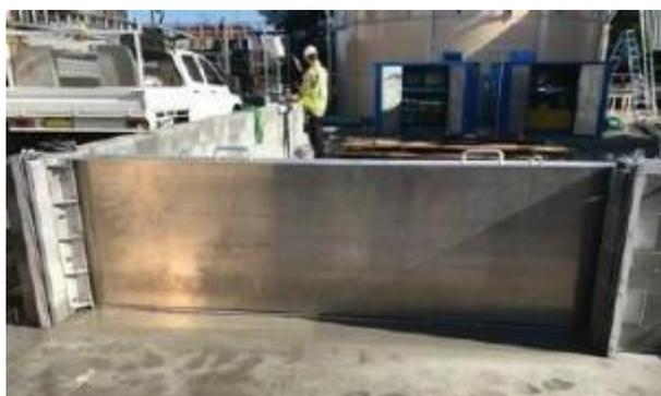
*Figura 42 – Paratoia di chiusura a scorrimento orizzontale per un cancello a tenuta idraulica*
