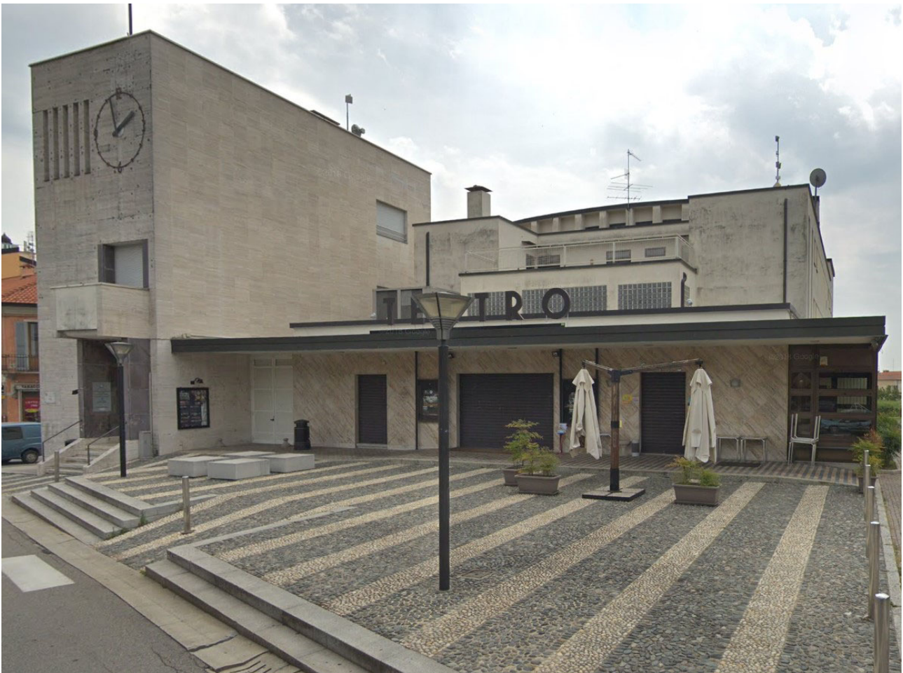
Vista attuale dell'edificio, oggetto di intervento
