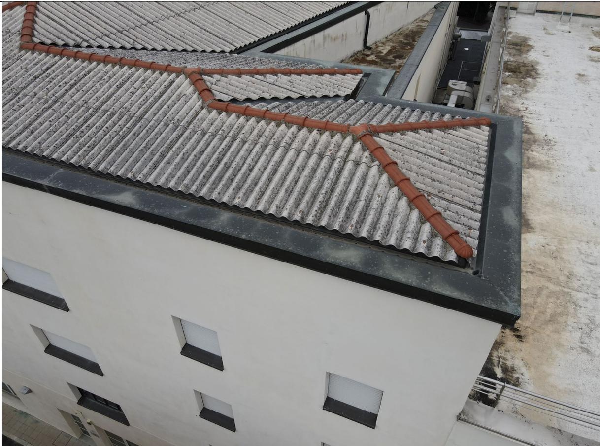
Fig. 3 – dettaglio della copertura con scossalina perimetrale in rame e colmo in laterizio
