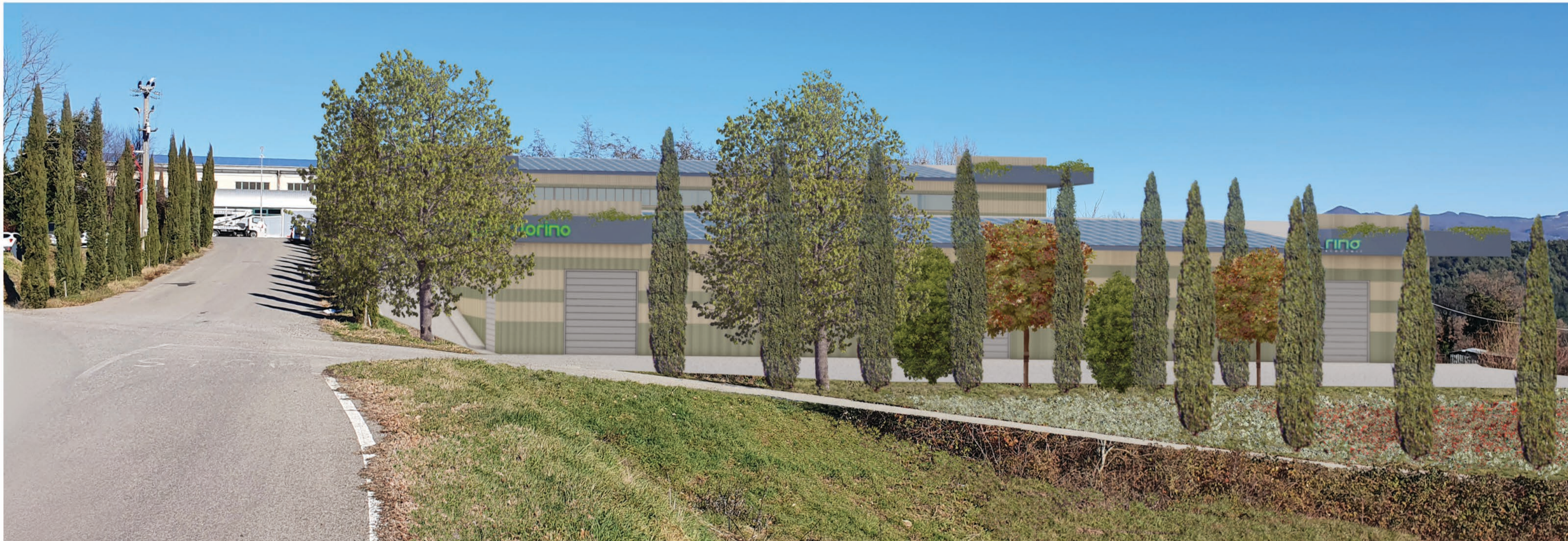
Zoom sull'ingresso al nuovo capannone industriale
