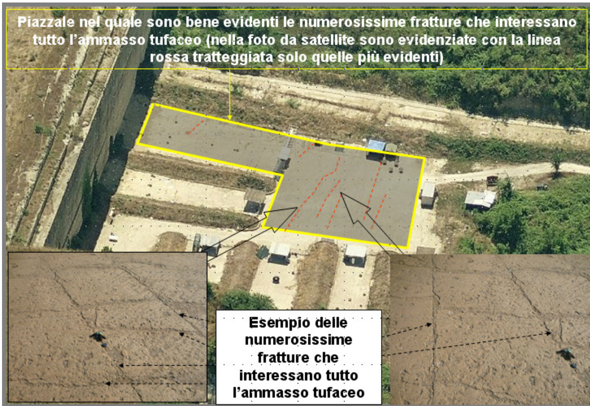
Figura 6: La cava di tufo di Pian dell'Olmo: evidenza della fitta fratturazione che interessa tutto l'ammasso tufaceo come è rilevabile nella parte di piazzale nel quale il tufo affiora (area nel riquadro giallo). Le foto illustrano la fitta maglia di discontinuità che rende molto permeabile il tufo. Come si vede si tratta di una cava che è in parte a fossa, delimitata su due lati da pareti instabili subverticali.
