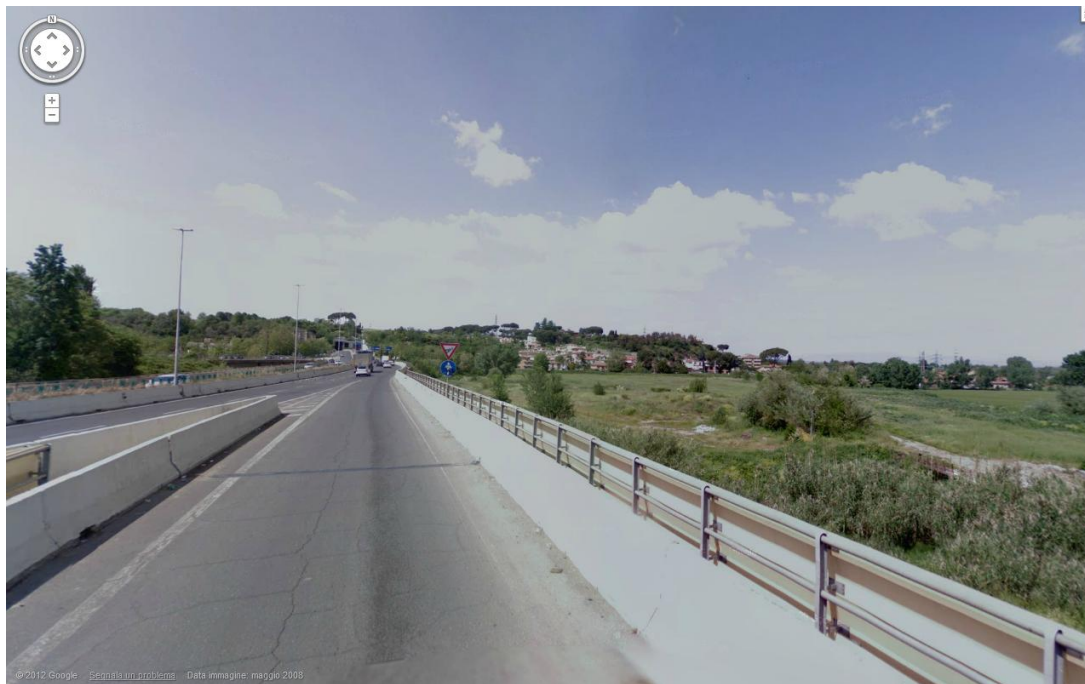
via Flaminia, imbocco su Viadotto Giubileo del 2000
