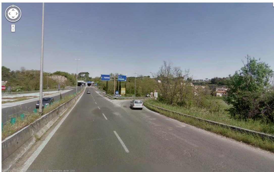
viadotto Giubileo del 2000, svolta per Prima Porta
