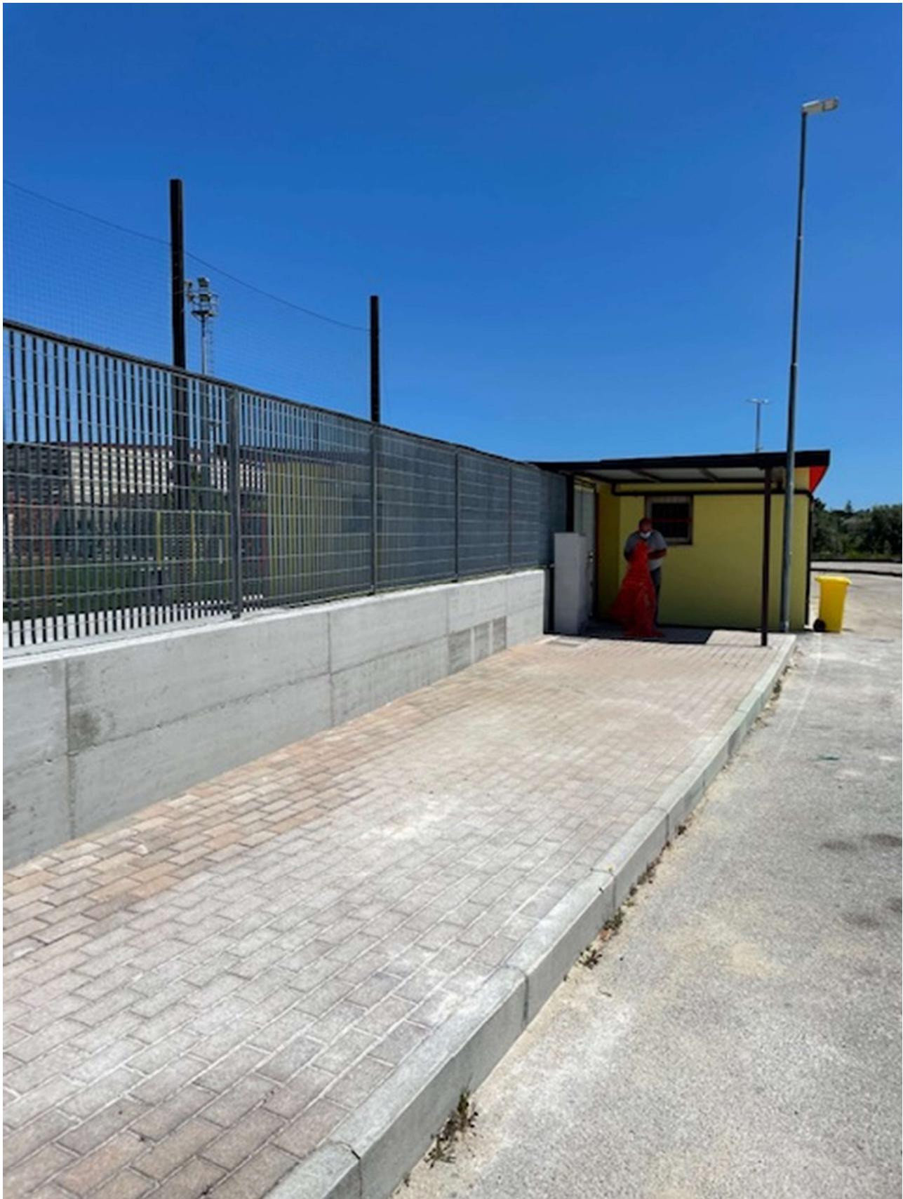
Foto 1 – Particolare realizzazione muretto perimetrale e recinzione
