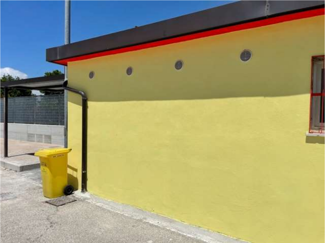
Foto 3 – Particolare rifacimento locale tecnico
