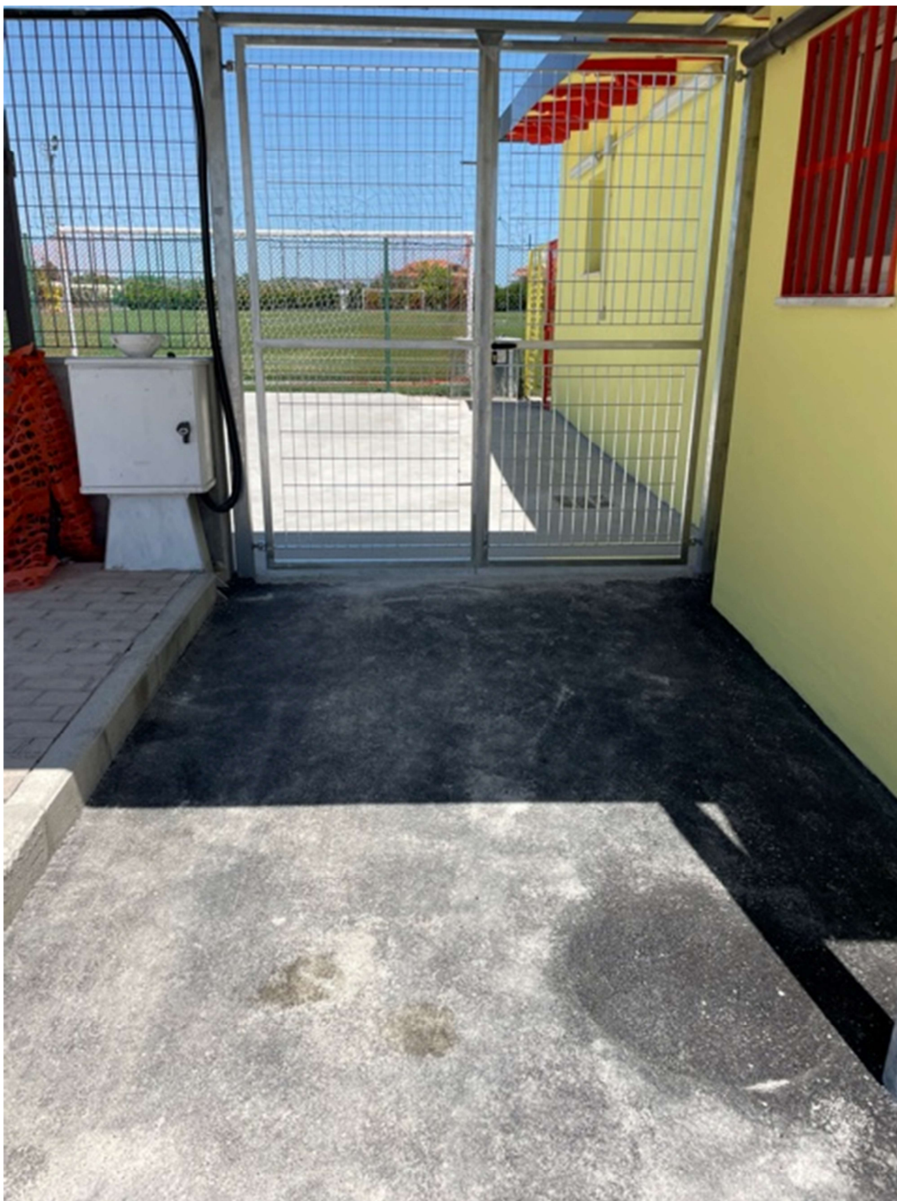
Foto 2 – Particolare realizzazione scivolo disabili e piazzale
