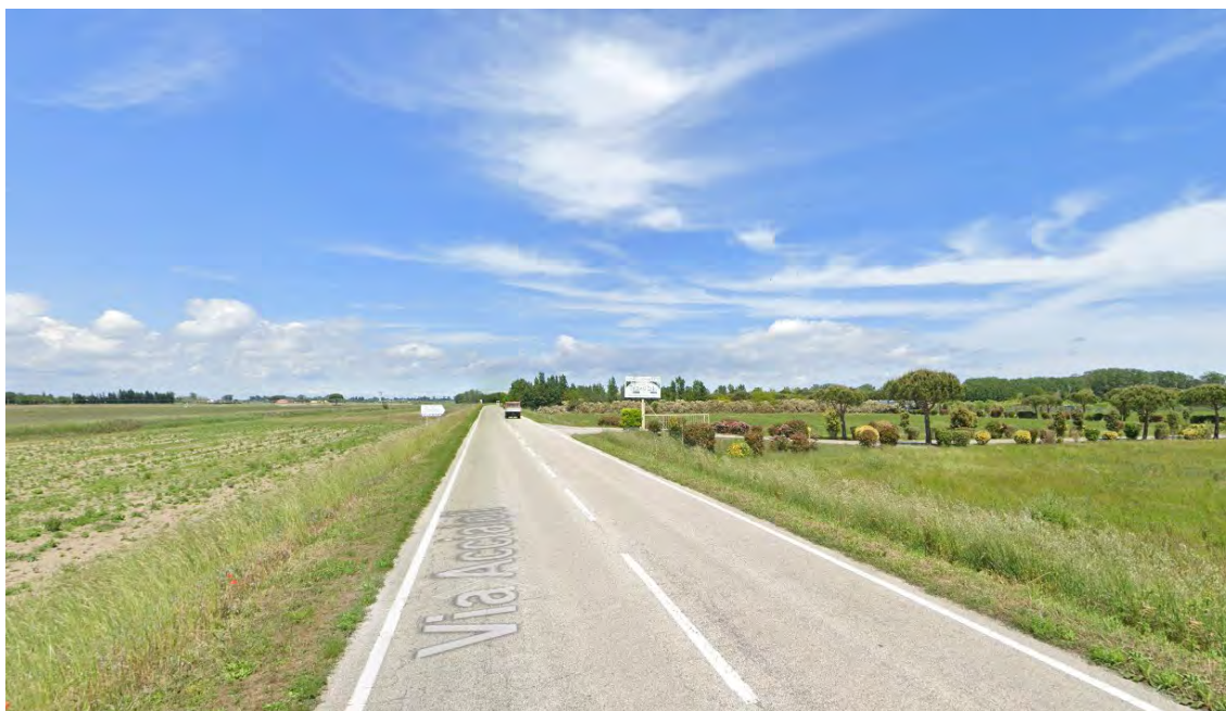
Figura 2 Zona di ingresso all'area di progetto
