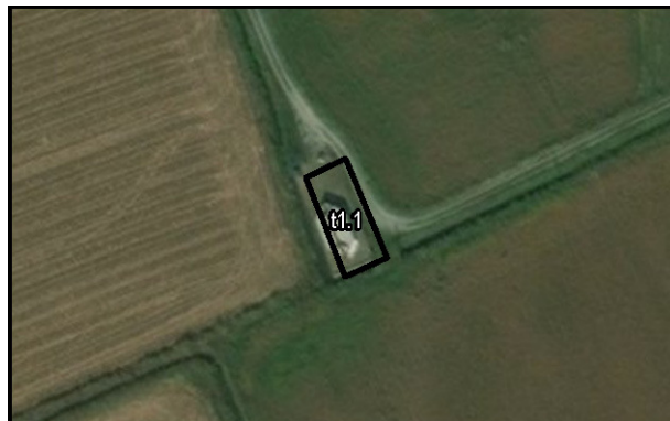
Figura 84 Cabina gas. Foto aerea
