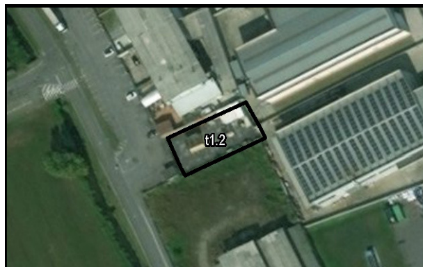
Figura 86 Cabina elettrica. Foto aerea
