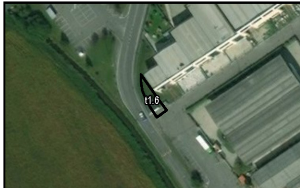
Figura 8 Cabina elettrica. Foto aerea
