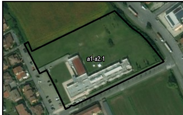
Figura 4 Scuola Elementare Gianni Rodari. Foto aerea
