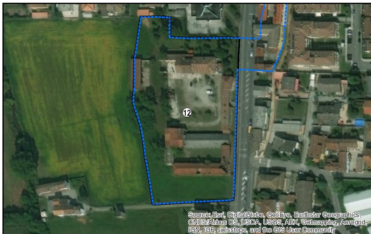
Figura 26 Isolato 12 (Cascina Motta Vigana): foto aerea
