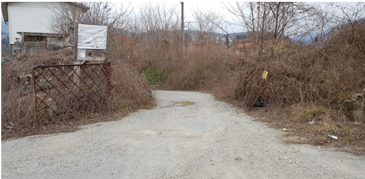
FOTO 14 – ACCESSO SOTTOPASSO DA AREA EX-PARIGINE
