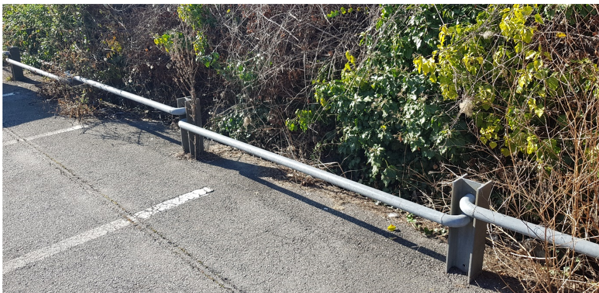
FOTO 7 – PARTICOLARE GUARD-RAIL A PROTEZIONE DEL CANALE PER RACCOLTA ACQUE PARCHEGGIO
