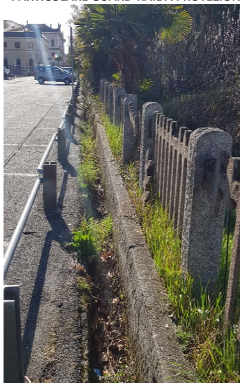
FOTO 8 – PARTICOLARE GUARD-RAIL A PROTEZIONE DEL CANALE PER RACCOLTA ACQUE PARCHEGGIO
