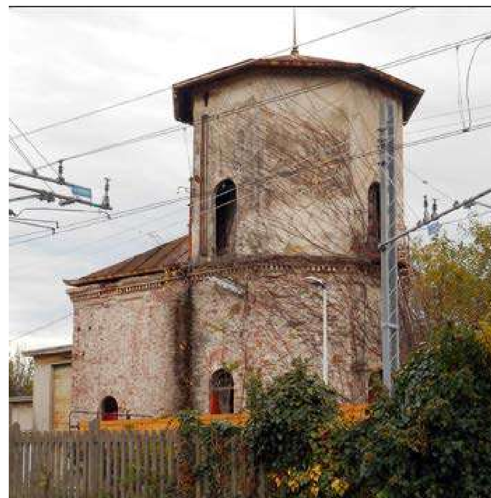
ALTRI FABBRICATI: MAGAZZINI PRESSO IL FABBRICATO VIAGGIATORI E TORRI DI SERVIZIO
