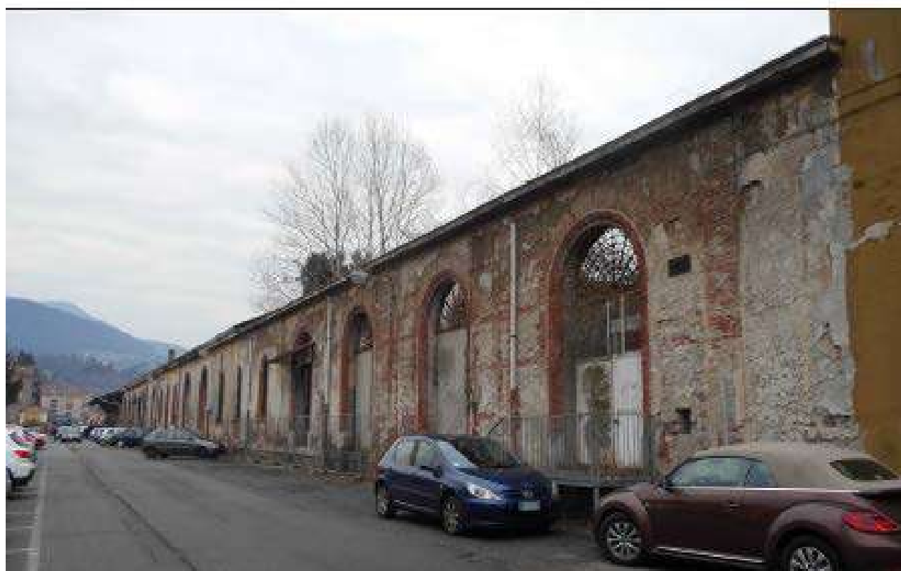
MAGAZZINO IN V LOCALE - Facciata continua verso il piazzale esterno, veduta da nord e da sud. Le ampie lacune dell'intonaco lasciano intravedere il sistema costruttivo, con muratura mista di pietra alternata a corsi di mattoni
