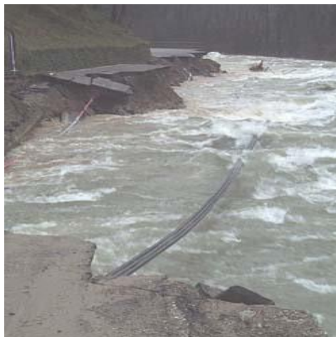
Foto – Frana di Cremenaga e crollo della Sp 61 in seguito all'erosione della sponda per opera del fiume Tresa in piena – maggio-novembre 2002
