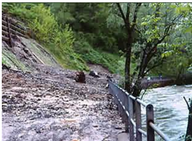
Foto – Frana di Cremenaga e crollo della Sp 61 in seguito all'erosione della sponda per opera del fiume Tresa in piena – maggio-novembre 2002
