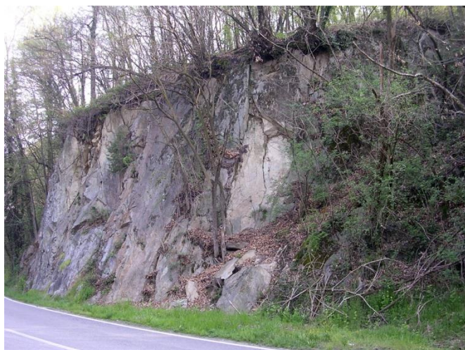
Foto: parete rocciosa, con presenza di alcune fessurazioni non particolarmente evidenti, ubicata a monte della strada del Cucco (via Gorizia), nelle immediate vicinanze del confine comunale con Montegrino Valtravaglia.
