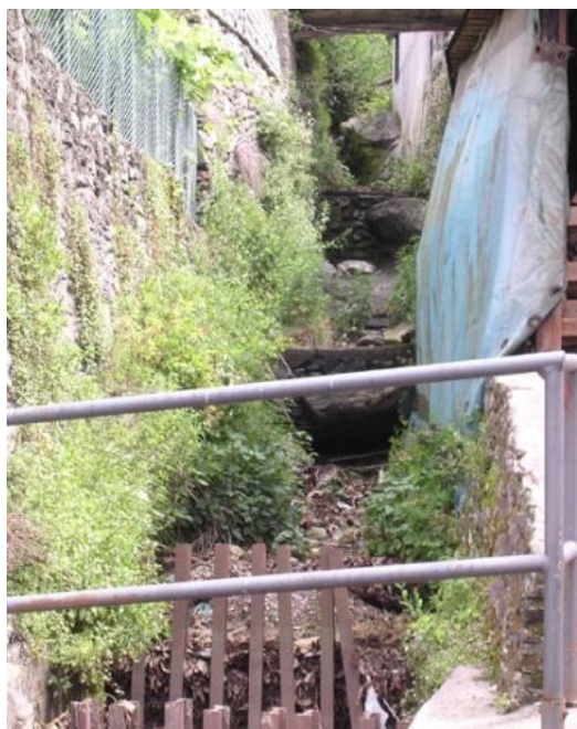
Foto a Sx.:Valleggio a monte di via Bertoni (Colmegna). Foto a Dx: La tubatura sottodimensionata entro le quali le acque del ruscello dovrebbero convogliarsi.
