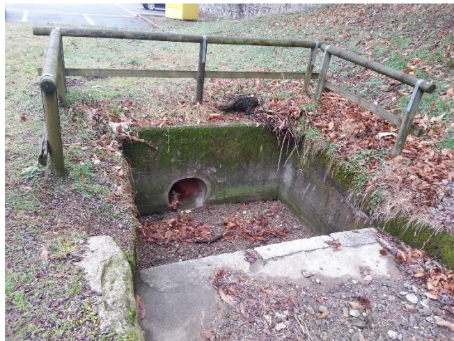
Foto – sx: ingresso tratto intubato torrente Luina. Dx. Ingresso tratto intubato roggia a monte del parcheggio del cimitero
