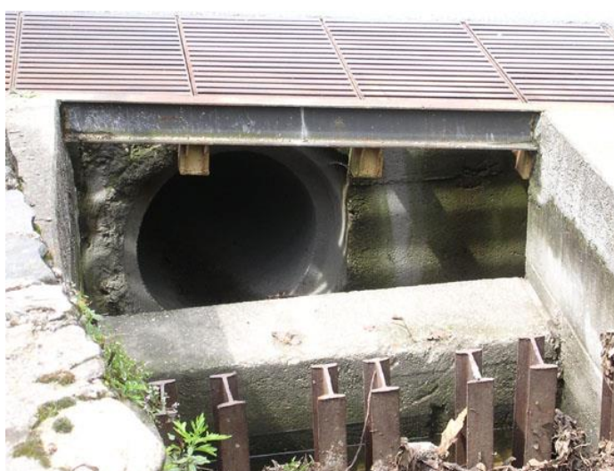
Foto a Sx.:Valleggio a monte di via Bertoni (Colmegna). Foto a Dx: La tubatura sottodimensionata entro le quali le acque del ruscello dovrebbero convogliarsi.
