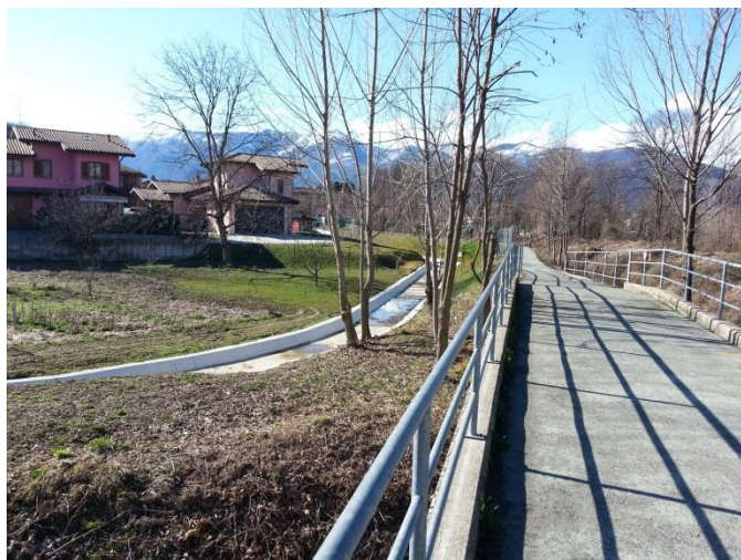
Foto: Canale scolmatore e Vasca Volano poste in località Premaggio (Germignaga e Luino) al fine di contenere le portate del fosso Mondiscia
