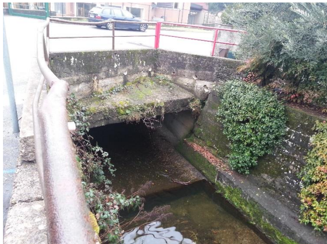
Foto – sx: ingresso tratto intubato torrente Luina. Dx. Ingresso tratto intubato roggia a monte del parcheggio del cimitero
