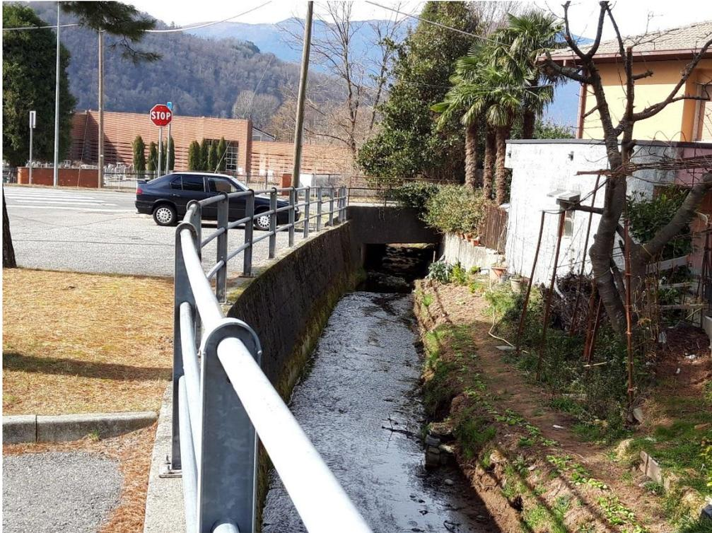
Figura 46. Il ponticello a luce insufficiente di via Copelli.
