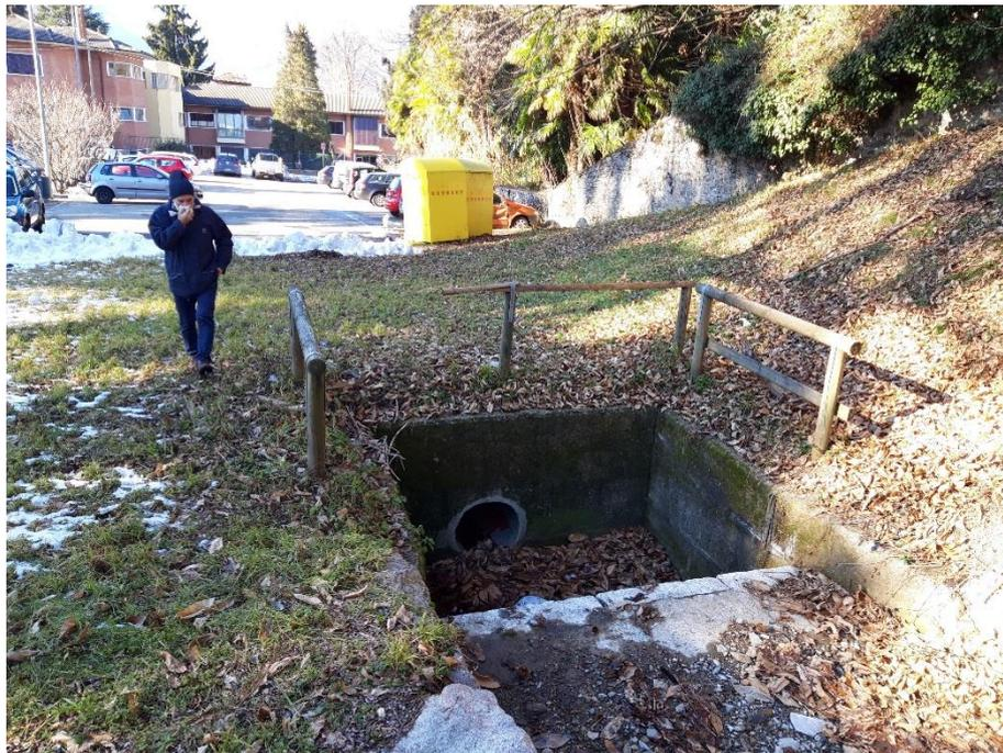
Figura 52. Imbocco della tombinatura del torrente Moncucco.
