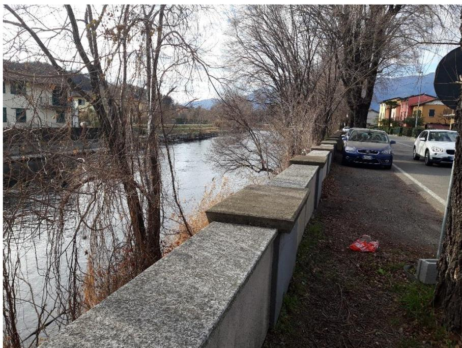
Figura 8. Fiume Tresa lungo via Don Piero Folli: si noti il muretto per contenere le piene.
