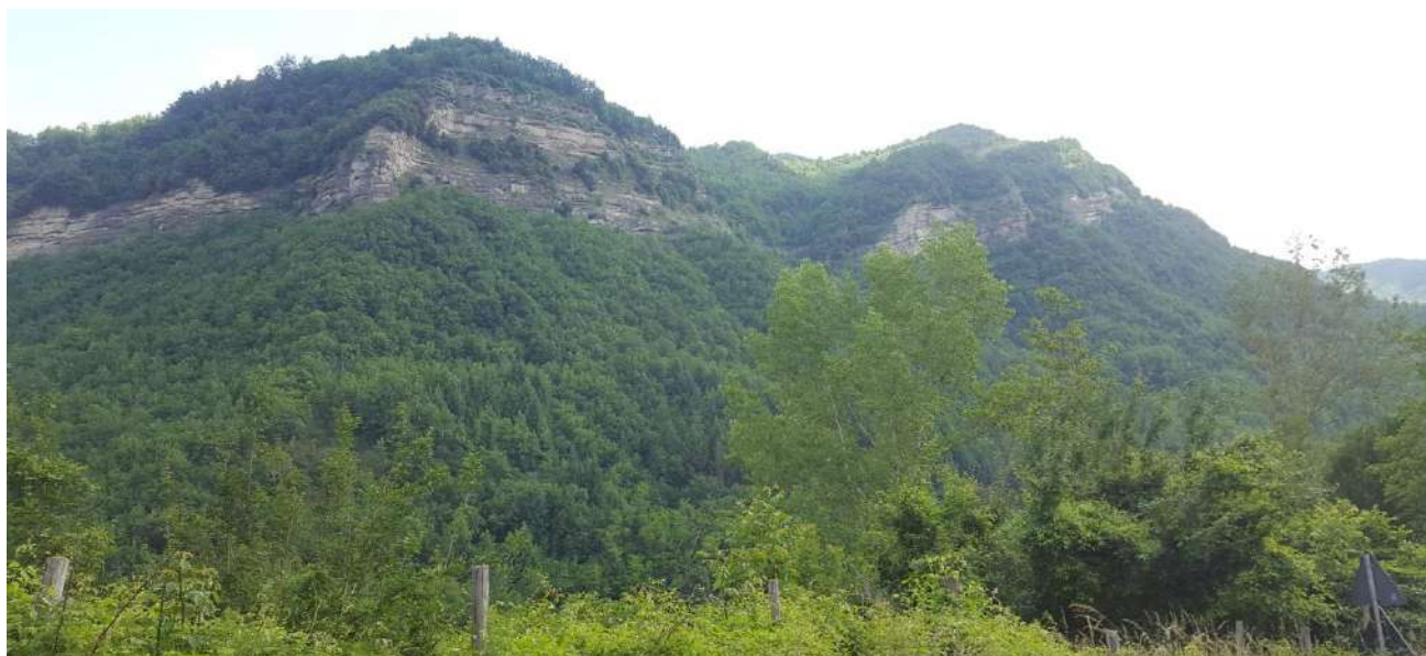
Vista d'insieme delle zone di alimentazione della frana di crollo 1672-Trisungo
