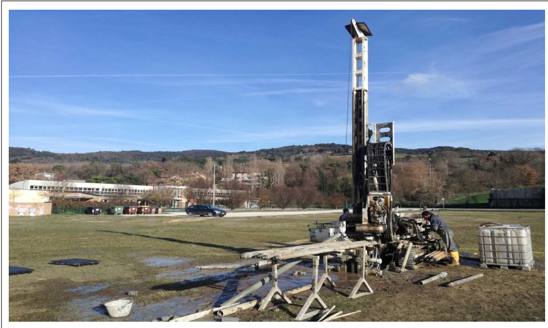
- Sondaggio S1, posizionamento macchina operatrice
