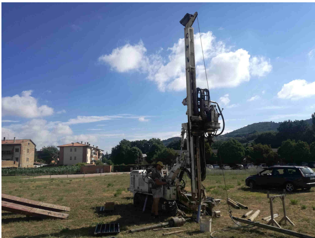
Nuova Scuola Deruta - Posizionamento macchina operatrice Sondaggio S1
