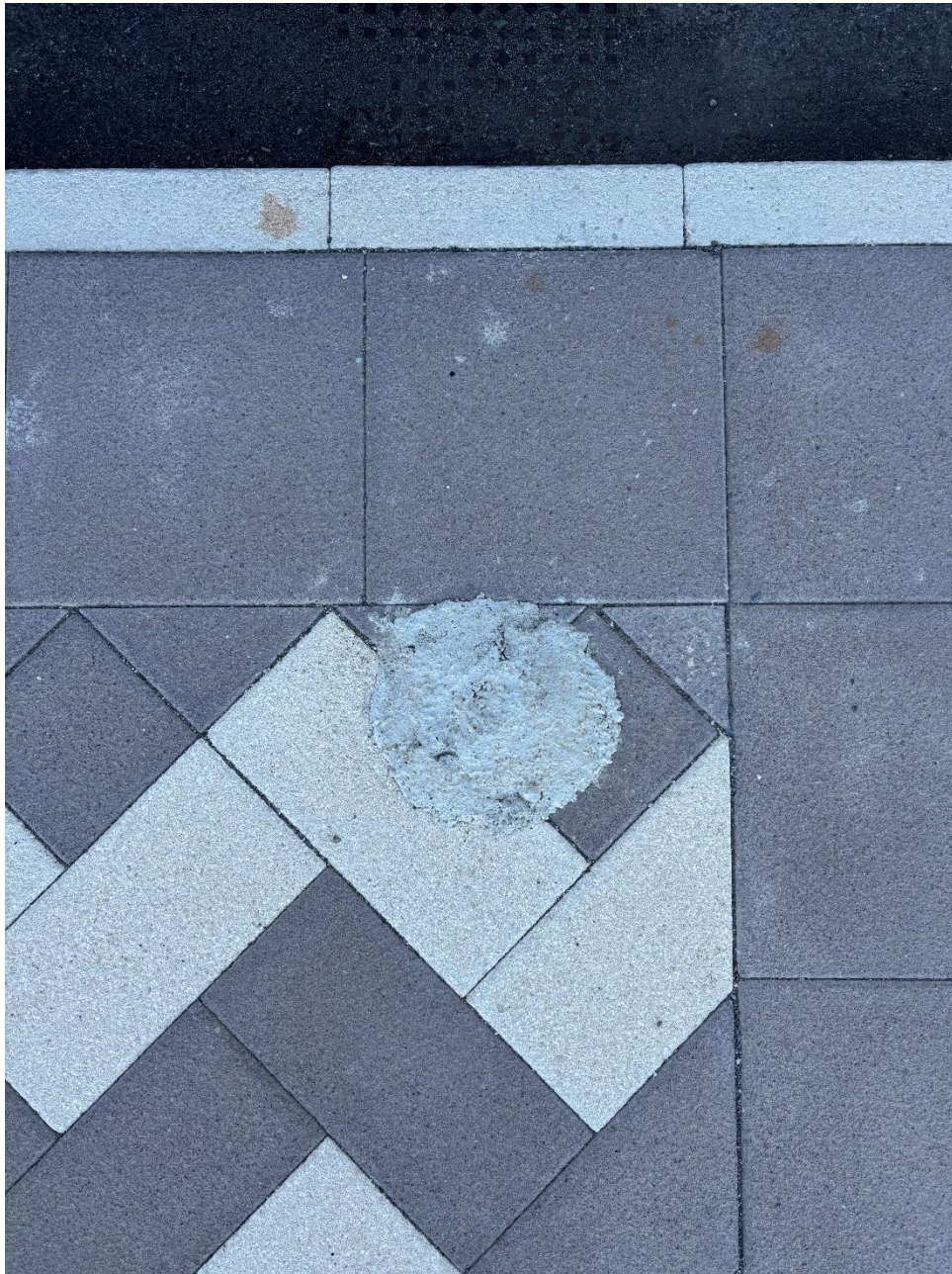
Foto 18 – predisposizione blocco di fondazione interrato con pozzetto integrato
