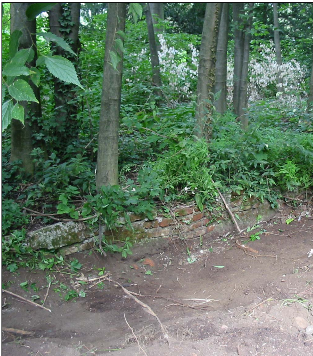
Foto 5 – Saggio S7 in corrispondenza del muretto in mattoni e malta che delimita la porzione Sud-est del Parco, poco più a Nord del saggio S6; la struttura del muro è abbastanza uniforme; nella foto si notano le radici degli alberi che, nati per disseminazione spontanea sopra il muretto, sono cresciute sotto lo stesso, in alcuni casi demolendone parzialmente la struttura (v. foto 6).
