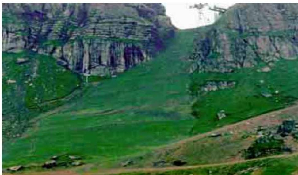
Inerbimento mediante la tecnica dell'idrosemina di un'opera di sostegno in terra rinforzata. Nell'immagine si può osservare la buona riuscita dell'intervento a distanza di pochi mesi dall'ultimazione dei lavori.
