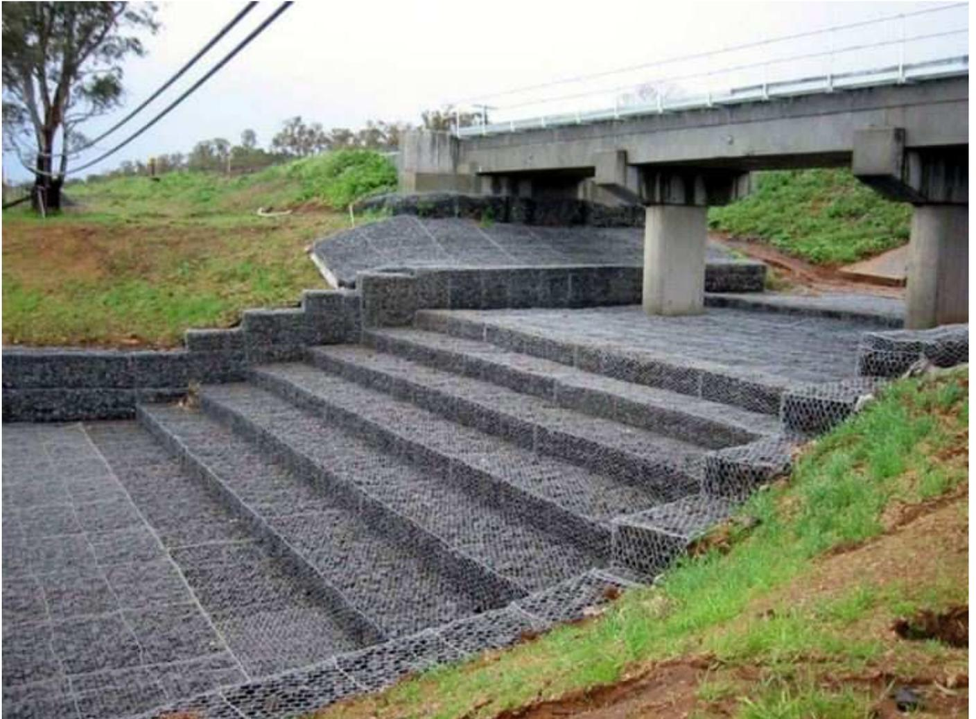
Fase di assemblaggio di un materasso in rete a doppia torsione per la sistemazione di un tratto fluviale.
