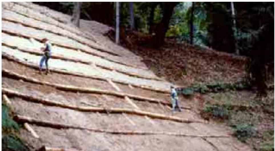
La grata viva è un sistema utilizzato con successo negli interventi di sistemazione e stabilizzazione di pendii in erosione o in frana, caratterizzati da inclinazione molto elevata (anche maggiore di 45°), dove non è possibile ridurre la pendenza con il modellamento dei versanti. Questo sistema garantisce, al tempo stesso, un'efficace azione di sostegno ed una protezione dall'erosione superficiale.
