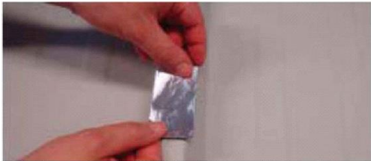
1) Posizionamento nastro CG-INT tra lamiera e profilo Solar-Flat
