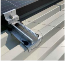
3) Installazione del rivetto RS AL.
