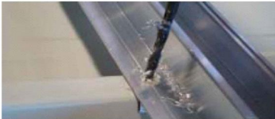
2) Foratura contemporanea della lamiera grecata e del profilo Solar-Flat
