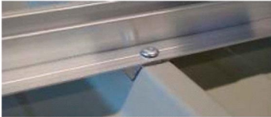
4) Fissaggio del rivetto RS AL sulla copertura.
