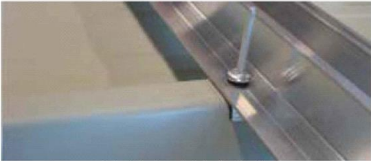
3) Installazione del rivetto RS AL.
