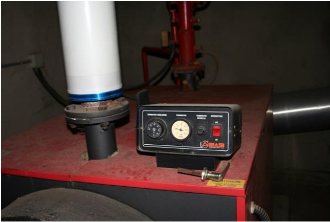
Termostato di Caldaia
