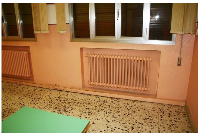
Pavimento con umidità di risalita PT
