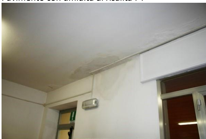
Infiltrazioni di acqua dal soffitto P1
