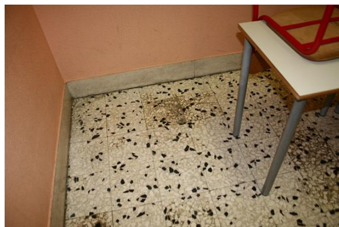
Pavimento con umidità di risalita PT
