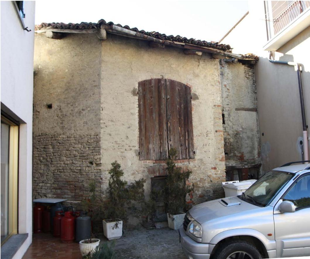
*Antico edificio agricolo con muratura in mattoni a vista intonacati e tetto con struttura in legno*
