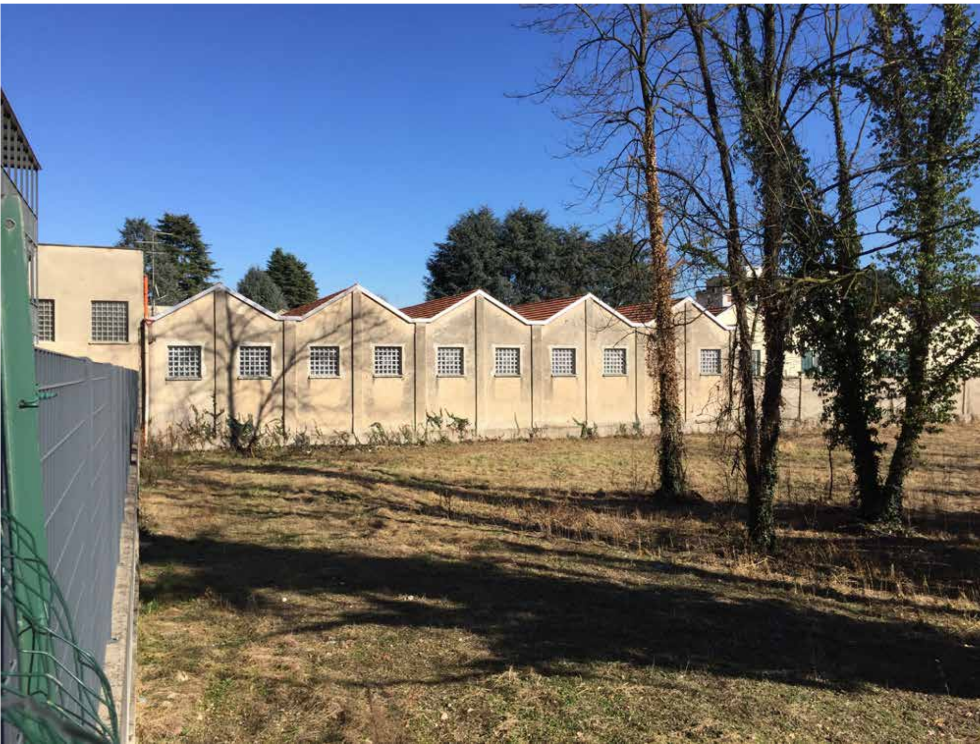
4- Inquadramento dell'area di intervento da via Sabotino verso est
