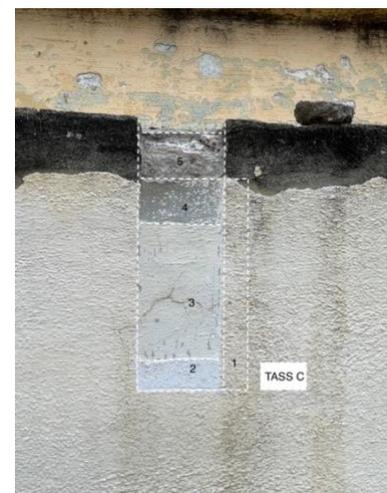
L'intervento del restauro datato 2006 stende un'ultima rasatura in malta di calce, sovrapponendola a quella cementizia liscia e compatta. Si tratta di intonachino sottile dall'aspetto granuloso (tipo rasatura "civile") di colore giallino (probabilmente colore a base calce). Questo intonachino è stato intercettato in tutte le porzioni indagate ad eccetto nella superficie interna dell'oculo, dove l'intervento del 2006 effettua solo la pitturazione.
