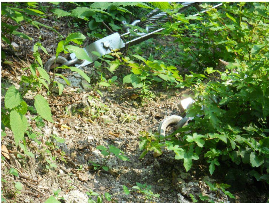
Foto 2 – Particolare ancoraggi laterali barriera paramassi Lato S.
