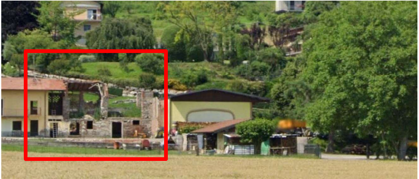
Ripresa Fotografica n. 7 - Contesto Circostante Porzione edificio crollata
