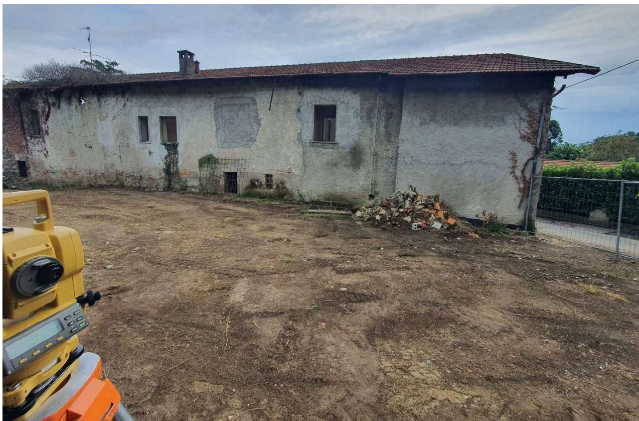
Ripresa Fotografica n. 6 – Lato Sud 2
