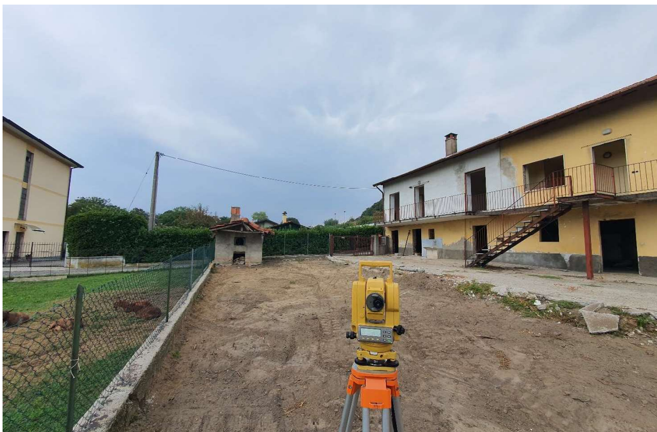
Ripresa Fotografica n. 2 – Cancellone d'Ingresso e Lato Nord 1
