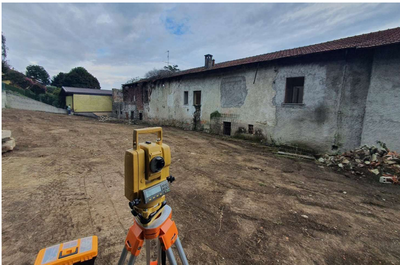
Ripresa Fotografica n. 5 – Lato Sud 1
