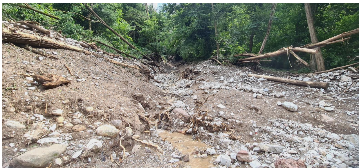
Fig. 9 Viste dalla zona di spaglio del materiale. Nell'ultima fotografia si vede il torrente che sale inciso lungo il pendio.
