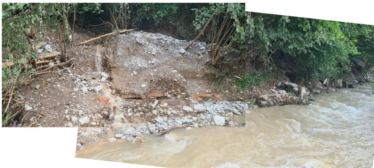
Fig. 5 vista della sponda destra orografica del Gombiera nella zona di confluenza dello Zuccone
