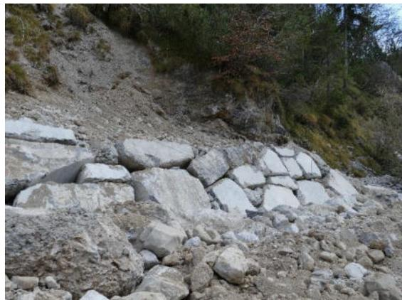
Figura 2 – Sistemazione versante in dissesto con scogliere in massi (sx) – dettaglio scogliera in massi (dx)
