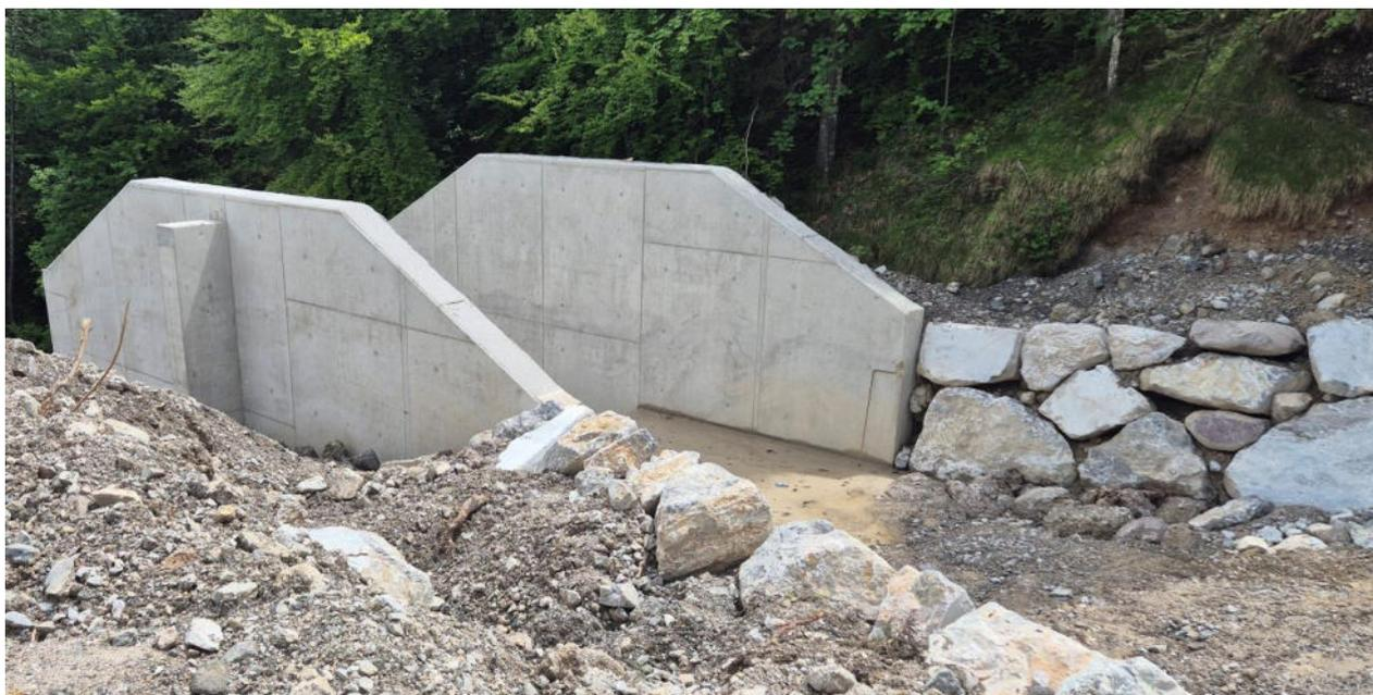
Figura 3 – Sistemazione versante in dissesto con scogliere in massi (sx) – dettaglio scogliera in massi (dx)
