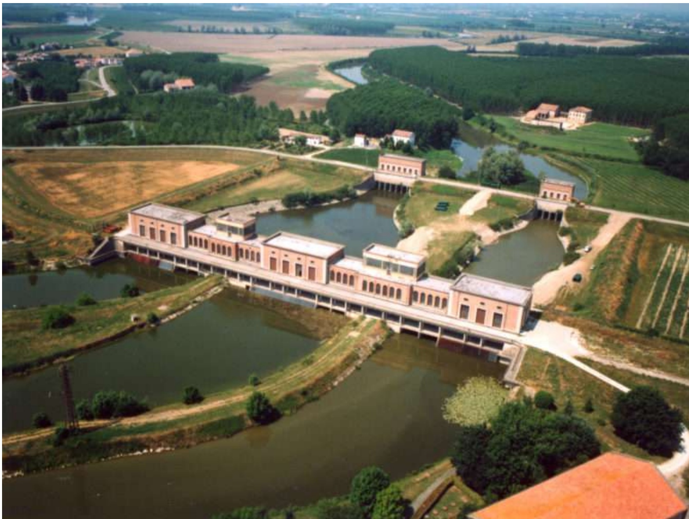
Fig. 18 Impianto Idrovoce di San Matteo delle Chiaviche gestito dal Consorzio di Bonifica Navarolo
