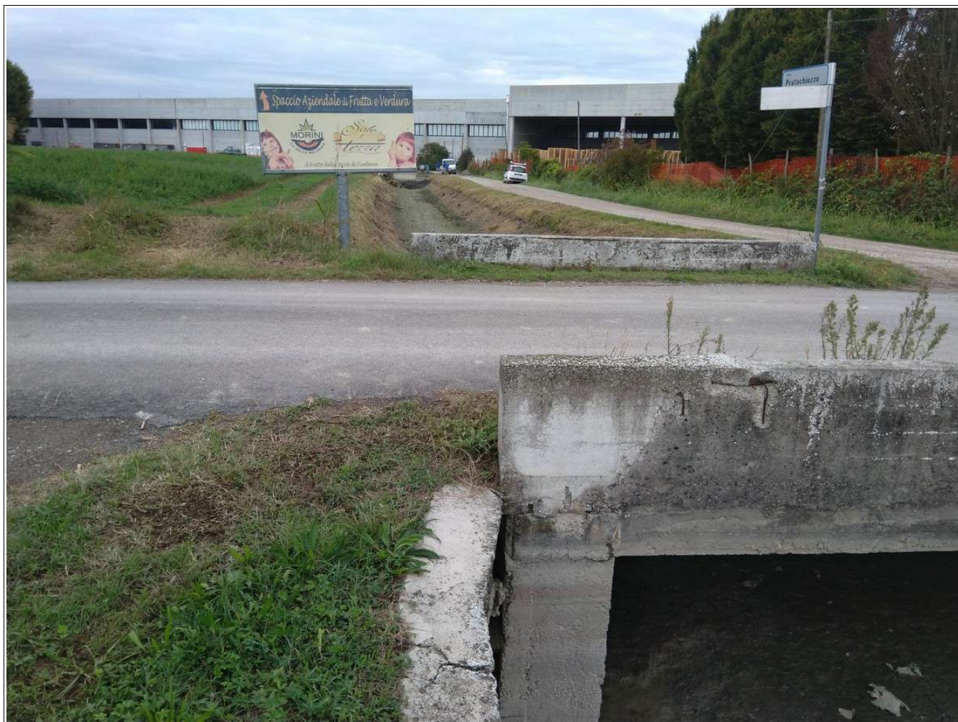
Fig. 25 - Foto del Canale Paralupa in corrispondenza dell'attraversamento di Via Feniletto
