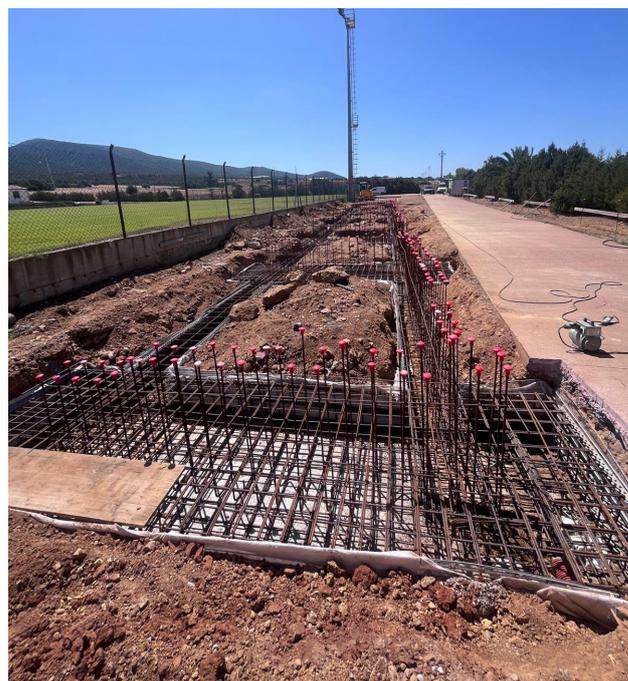
Le strutture portanti delle tribune saranno realizzate in opera in C.A. costituite da:
