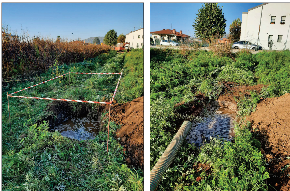
Fig. 4. Trincee esplorative e prova di invarianza idraulica
