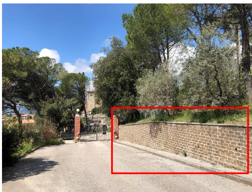
Area oggetto di intervento
