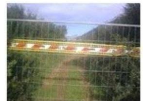
Fasi previste: Infissione paletti nel terreno e sistemazione rete di plastica; preparazione delle buche mediante scavo manuale con badile per porre in opera le colonne di sostegno delle ante dei cancelli e getto del calcestruzzo, previo ancoraggio, con elementi di legno delle colonne stesse. Collocazione su appositi supporti dei cartelli segnalatori con l'uso di chiodi, filo di ferro, ecc.
