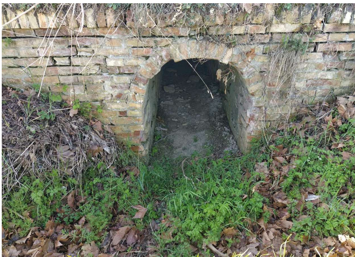
Foto 4.3 – Uscita attraversamento in muratura sulla S.: n° 73 bis
