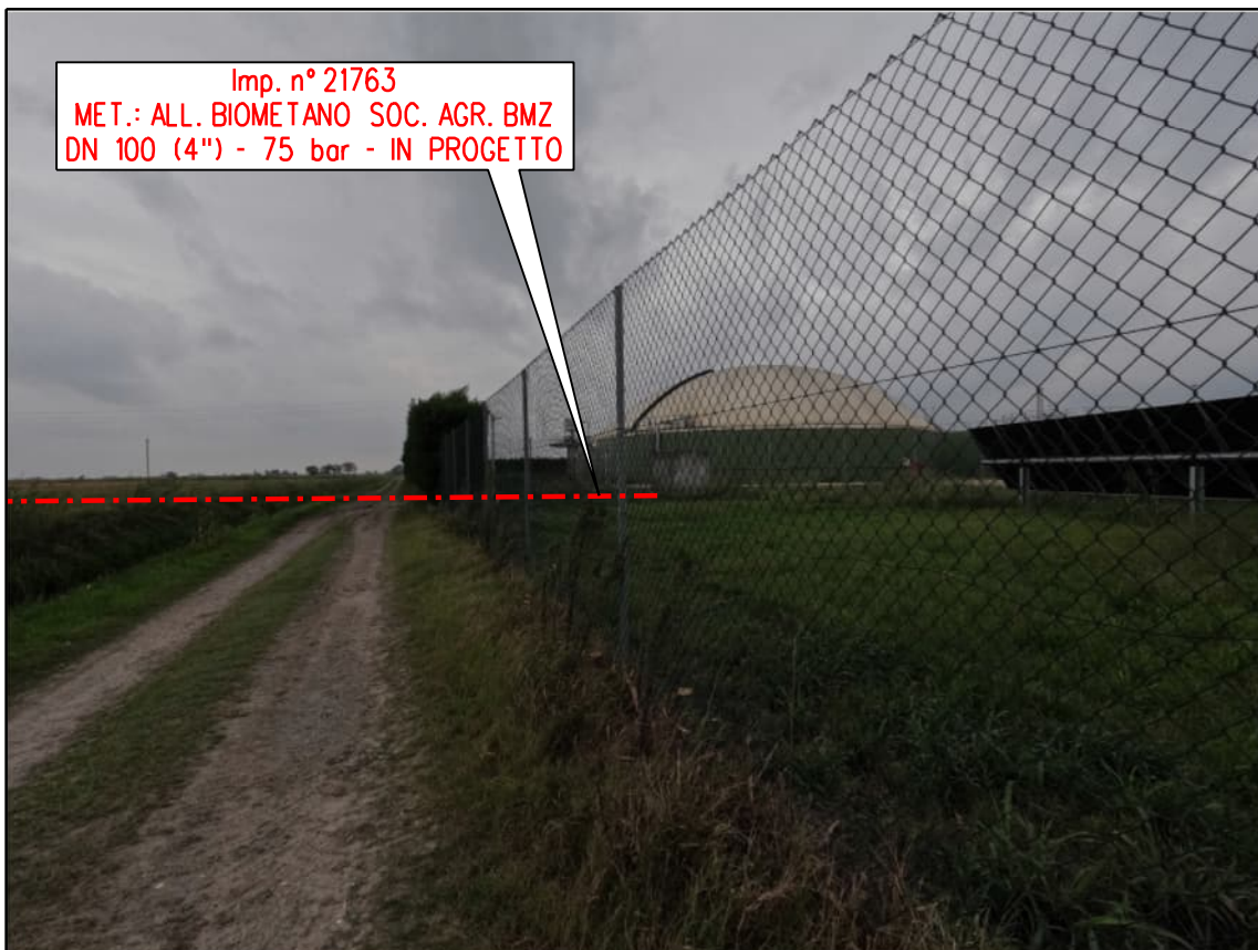
FOTO 2: VISTA PERCORRENCA IN AREA CAMPO PANNELLI FOTOVOLTAICI
