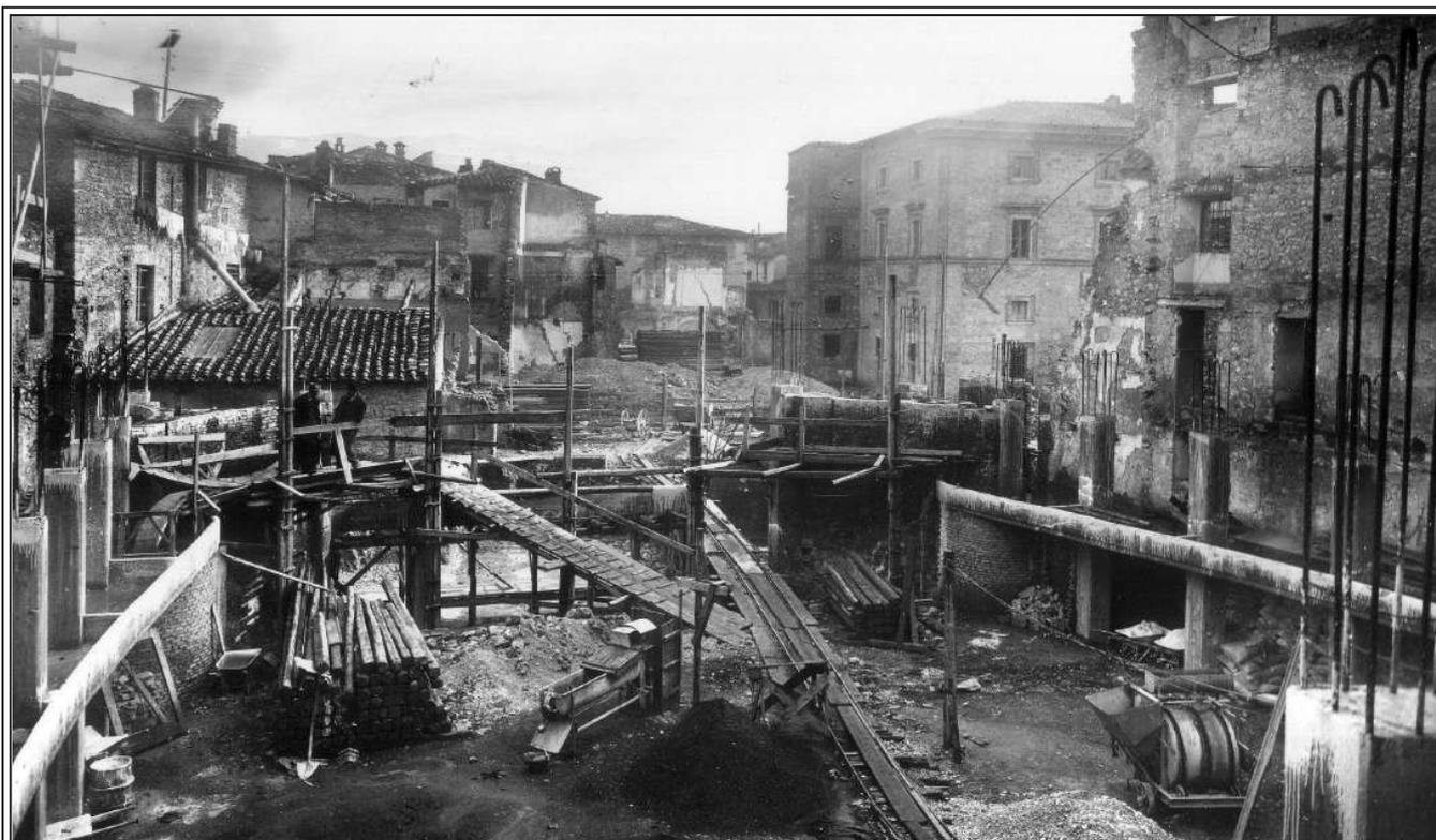
*Il grande vuoto lasciato dai bombardamenti, con il cantiere di ricostruzione da poco avviato nel 1947. Sono visibili lateralmente le nuove strutture verticali in calcestruzzo armato che cominciano ad innalzarsi.*
