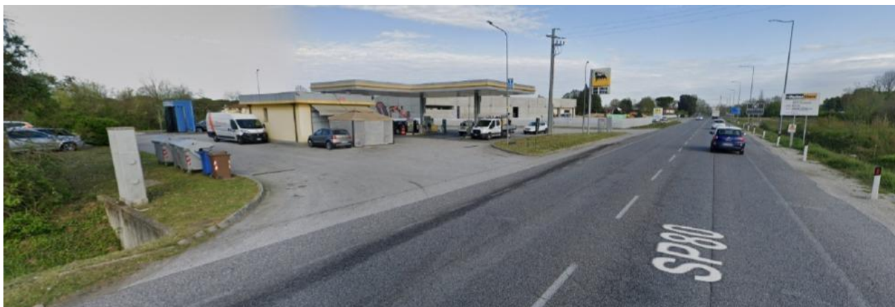
riprese impianto carburanti
