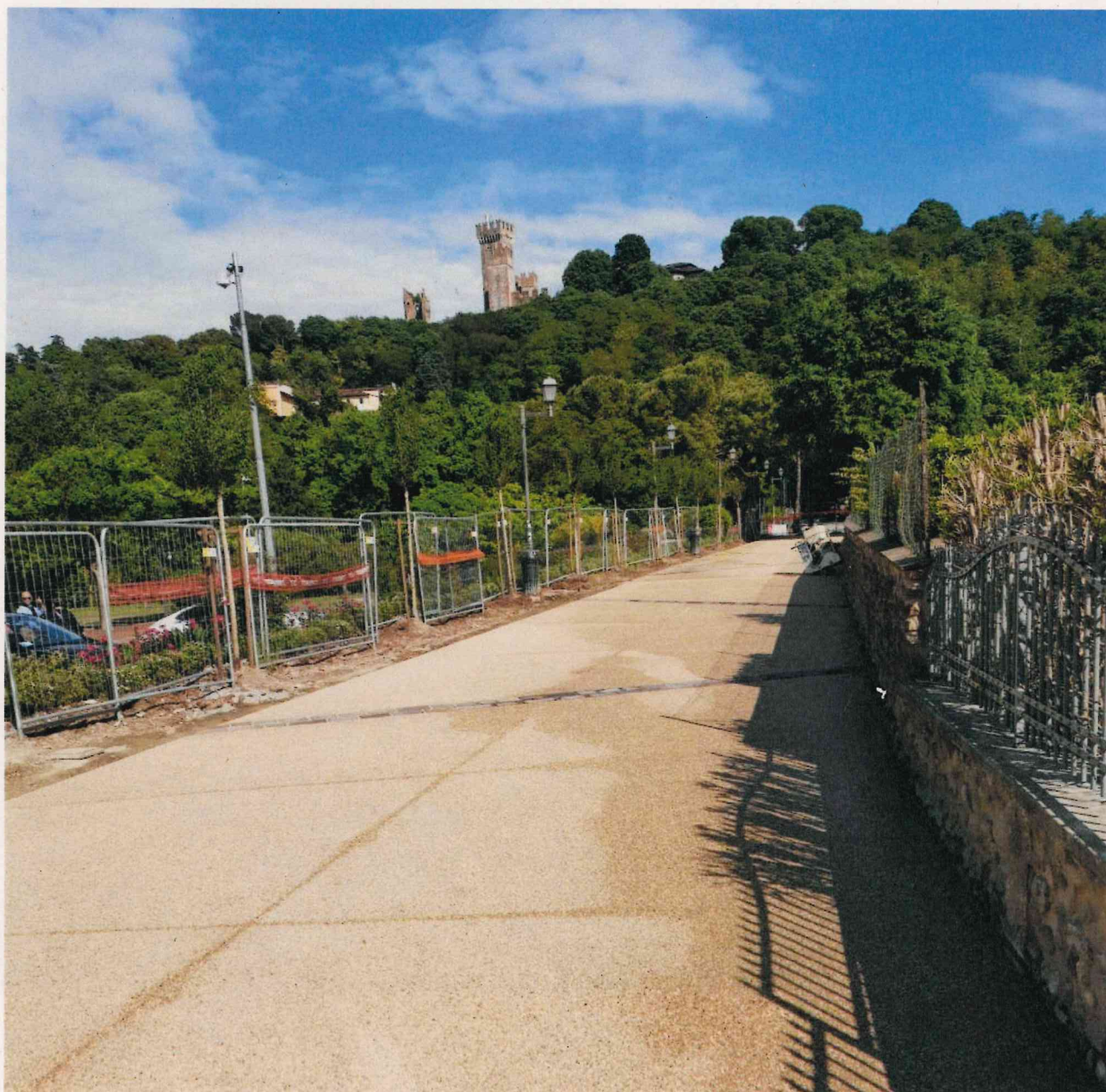
Vista della strada Raffaello Sanzio con le alberature nuove
