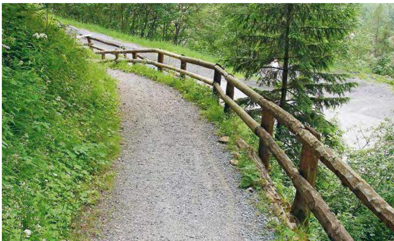
Fig. 24– parapetti in legno
