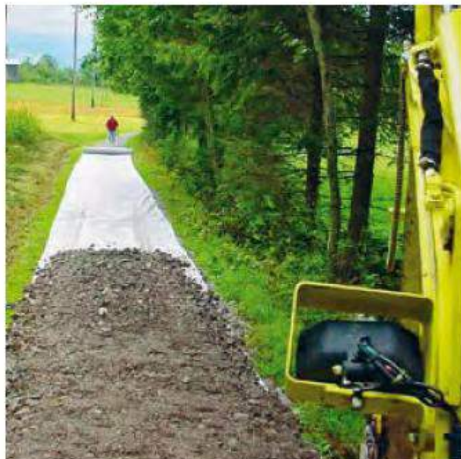
Fig. 14 - lo strato di fondazione viene posato dal davanti
