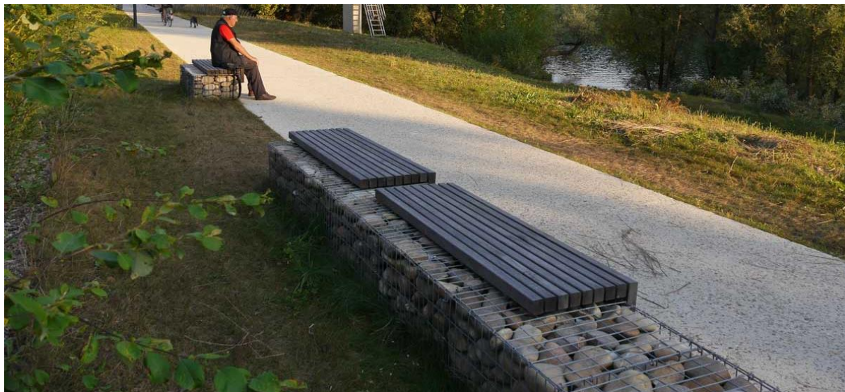
Fig. 7 - Esempio di sedute con gabbionate e vista panoramica in parco urbano
