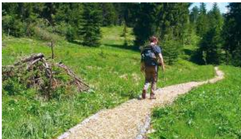
Fig. 13 - sentiero con strato di fondazione realizzato direttamente sul terreno naturale
