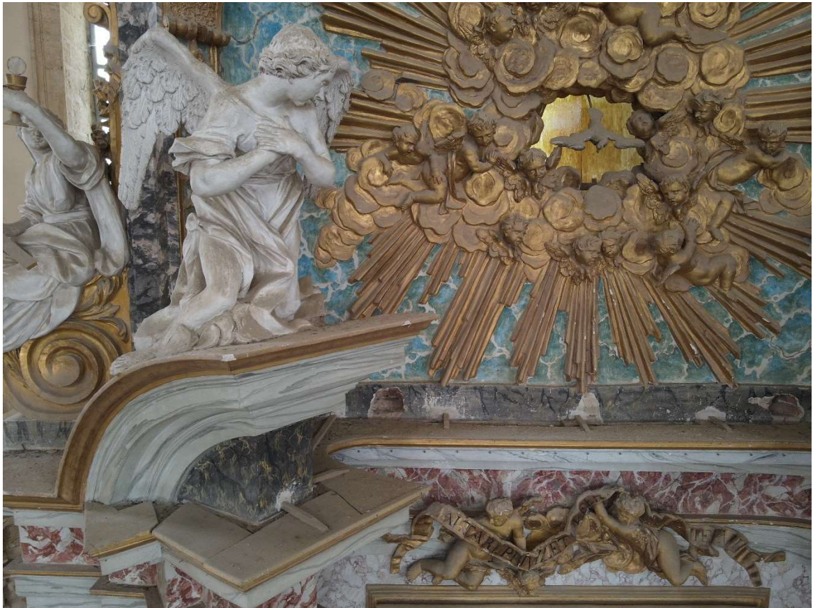
Foto 8 – Vista timpano curvilineo lato sinistro
